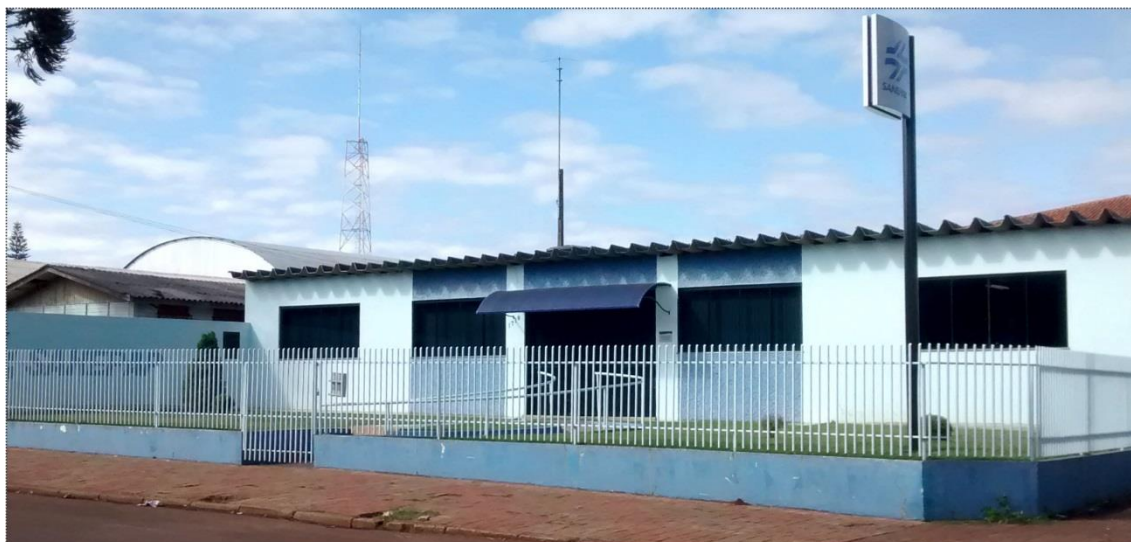
Figura 48 – Companhia de Saneamento do Paraná em Laranjeiras do Sul. Fotos: Tiago Elias Chaouiche (2015)
