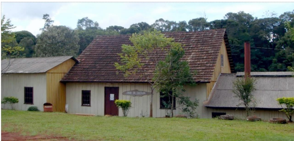
Figura 40 – Casa da Cultura de Boa Ventura de São Roque, em 2012. Foto da internet. Disponível em < http://www.panoramio.com/photo/64533283 >. Acesso 20.dez.2016.
