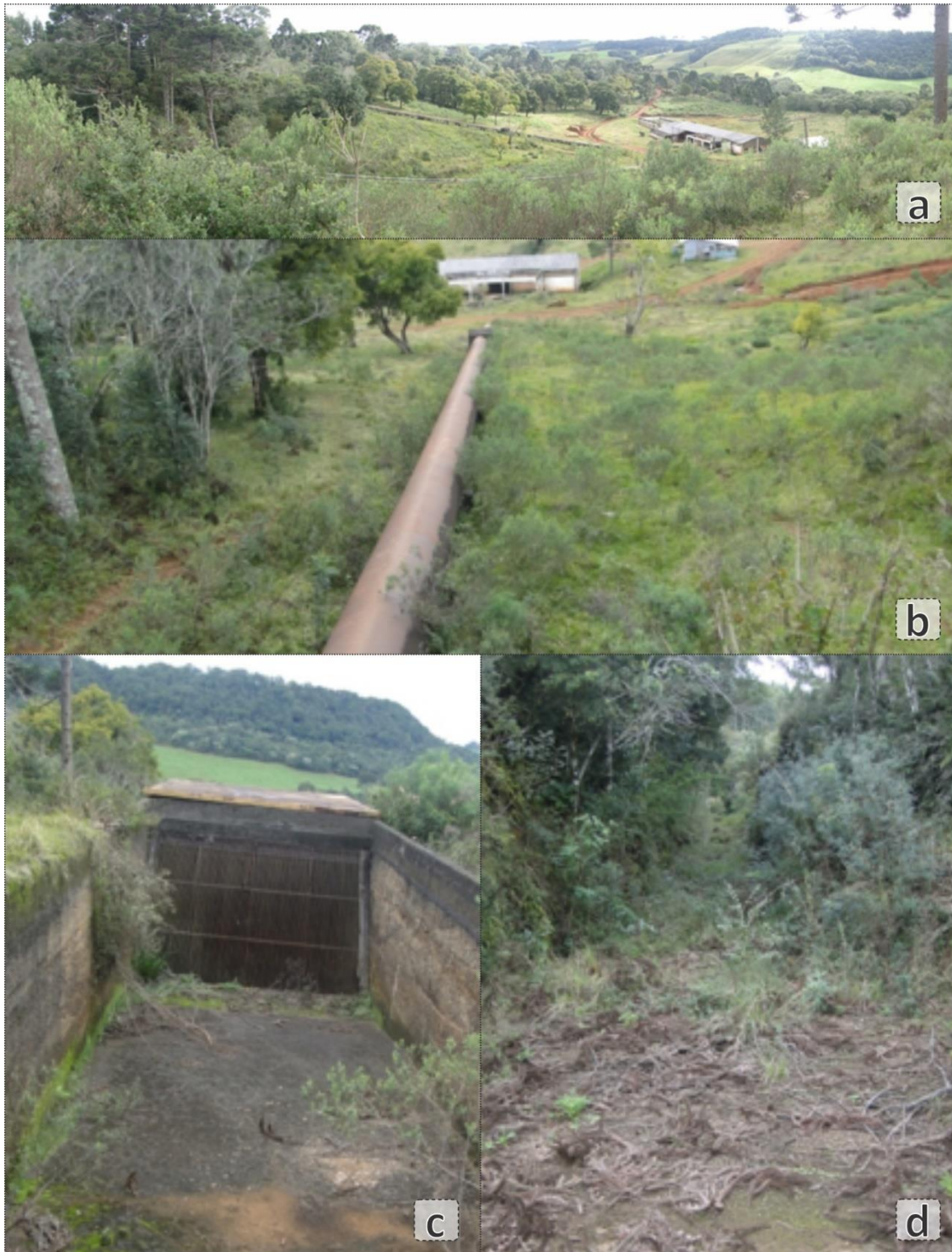
Figura 18 -Vista das obras instaladas evidenciando a consolidação das obras [a] panorâmica da tubulação forçada e casa de força; [b] detalhe da tubulação forçada; [c] detalhe da tomada de água; [d] detalhe do canal, que requer limpeza.
