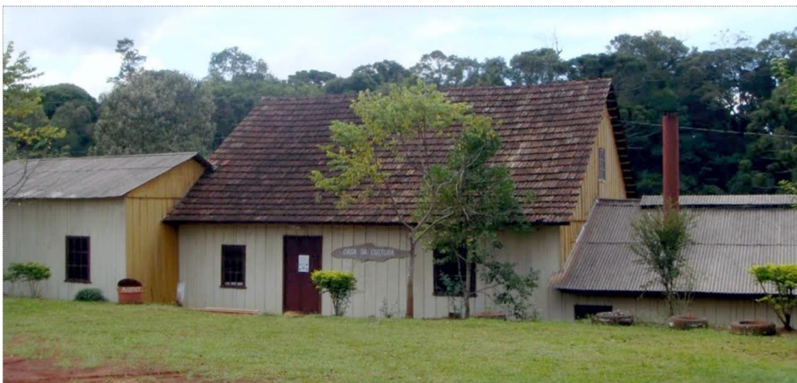
Figura 11 – Casa da Cultura de Boa Ventura de São Roque, em 2012. Foto da internet. Disponível em < http://www.panoramio.com/photo/64533283 >. Acesso 08 jun.2018
