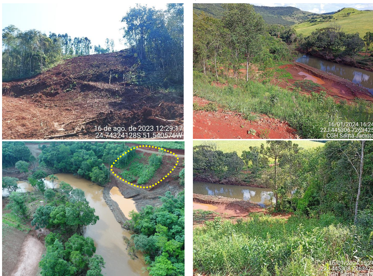
Figura 8: Evolução da sementeira no talude do antigo espelho de emboque do túnel, na margem direita do rio Marrequinha.
