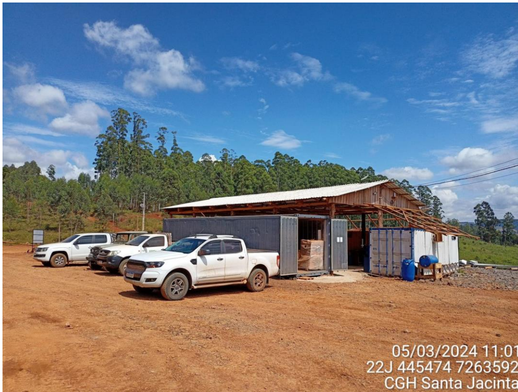
Figura 58: Barracão edificado para canteiro de obras, mas que deverá ser mantido para as atividades agrosilvopastoris da propriedade quando da operação do empreendimento.
