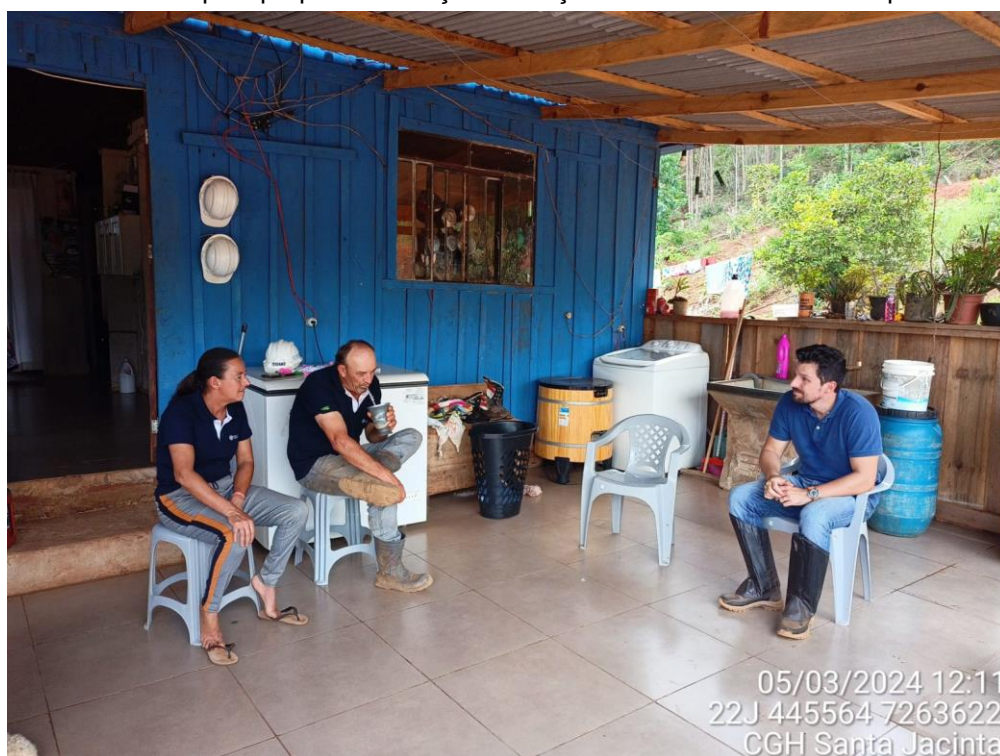
Figura 57: Moradia edificada na parte mais alta da fazenda para relocar a família Chavaren, que teve a casa afetada diretamente pela pequena alteração no traçado do canal adutor do empreendimento.
