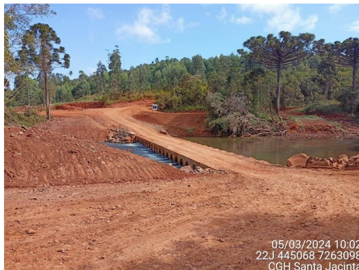
Figura 2: Travessia Malania Chavaren implantada em região que historicamente fazia-se a travessia pelo lajeado do rio Marrequinha.
