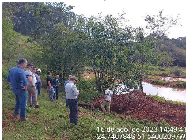
Visita técnica acompanhada por locais previamente ao início das escavações.
